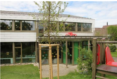
Schulanlage Zägli (Primarschulklassen)
