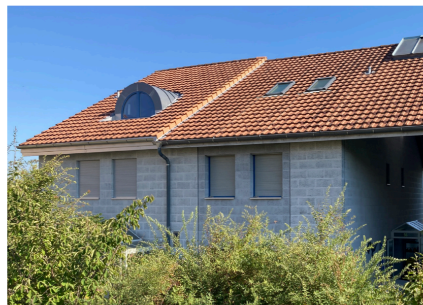
Nachgedämmtes Dach mit versetzter Regenrinne und Ortziegeln
