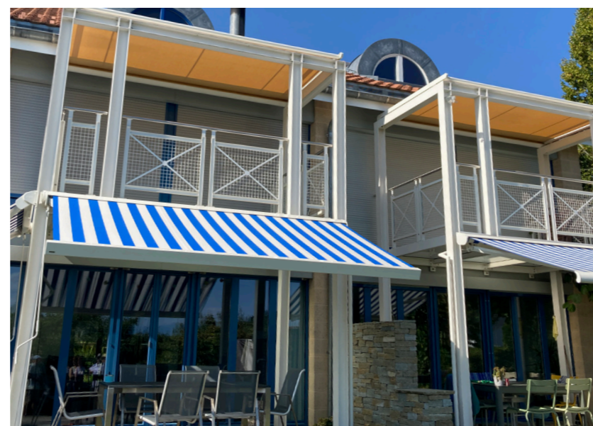
Fenster geschosshoch Gartenseite
