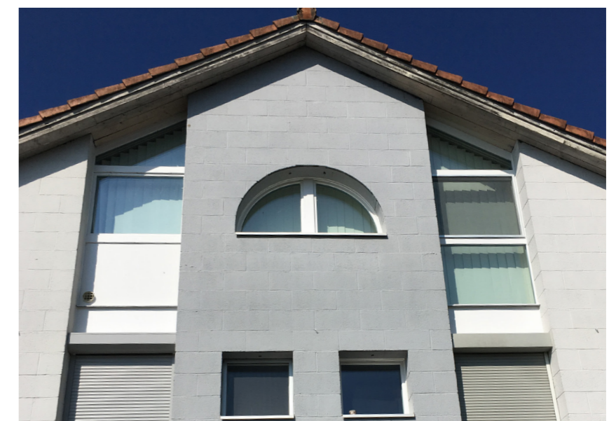
Vertikale Fensterbänder giebelseitig
