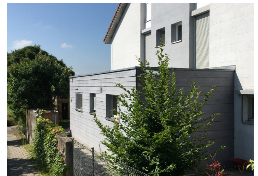
Spater hinzugefugter Anbau mit Flachdach
