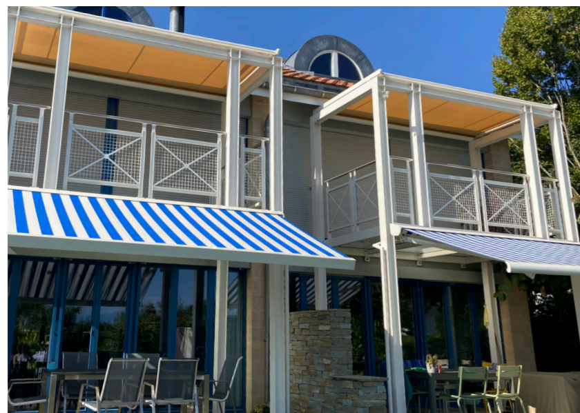
Ansicht Balkonkonstruktion mit charakteristischer Gelandergestaltung
