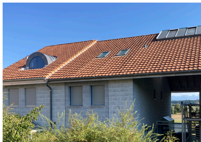
Dachflächenfenster auf Höhe Lukarne
