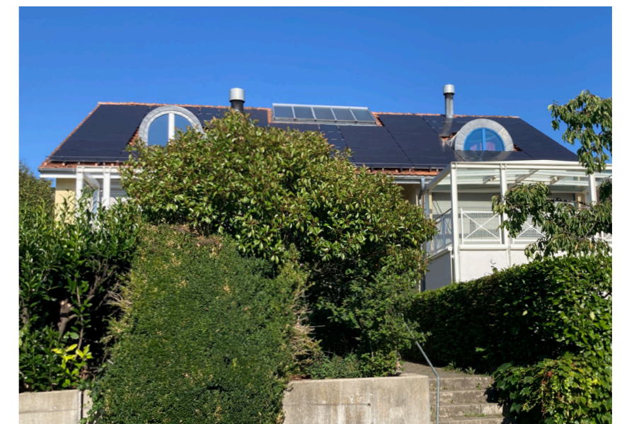
Koordinierte Aufdach-Anlage über Gesamtgebäude
