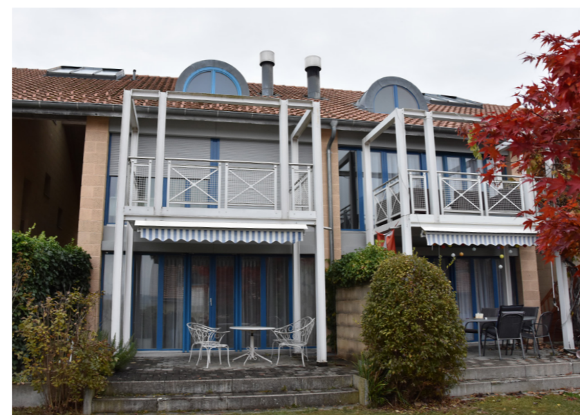
Situation gartenseitig, teilweise vorhandene Lichtschächte in Terrassen
